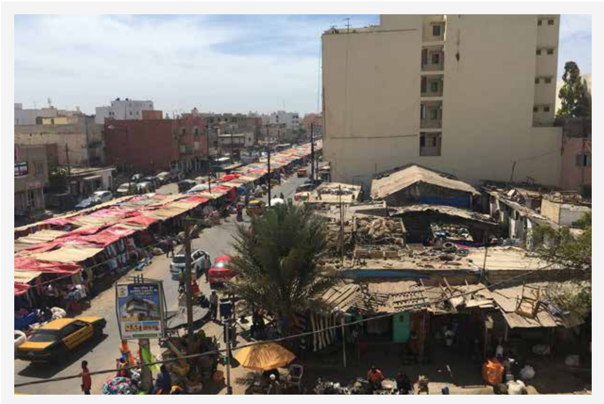
Image 5 : Stress : Fragilité des infrastructures – constructions non conformes.
