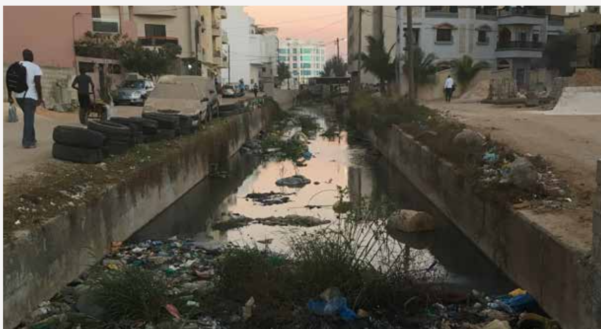
Image 2 : Stress : mauvaise gestion du métabolisme urbain – dépôt d'ordures sauvage dans les canaux de drainage des eaux pluviales. Source : CRPP (2019).
